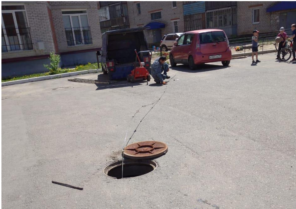
Прочистка сети канализации агрегатом «Питон»
